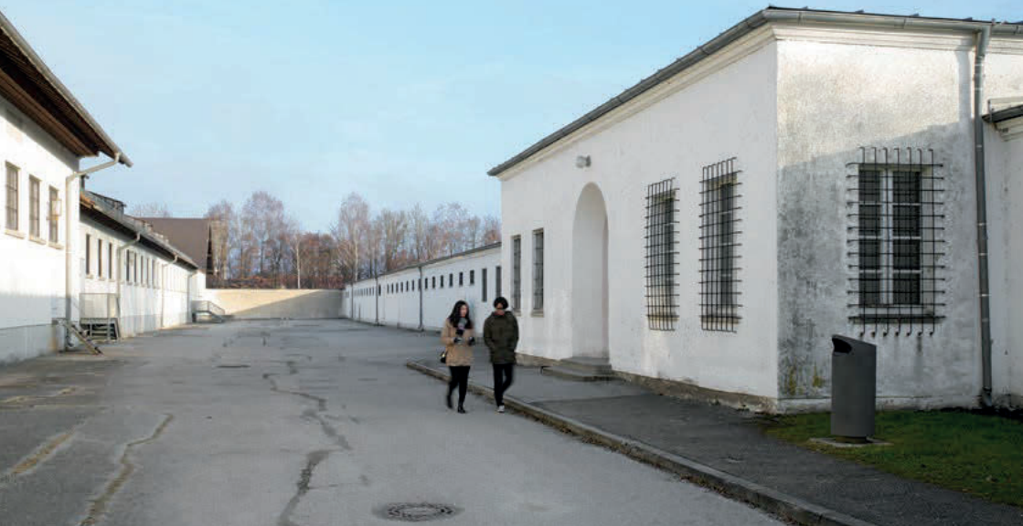
Blick in den früheren „Bunkerhof“ und auf den ehemaligen „Bunker“ (r.), 2017
