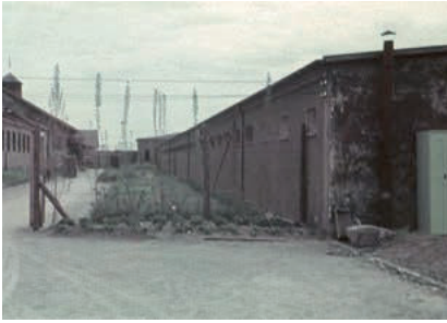
Blick auf den westlichen „Bunkerhof“. In der Mitte ist eine Wand sichtbar, die den „Bunkerhof“ unterteilte, Mai 1945
