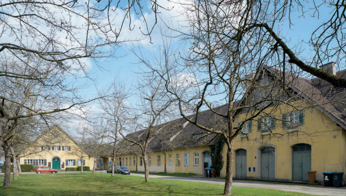
Ehemaliges Verwaltungs- und Institutsgebäude, 2017
